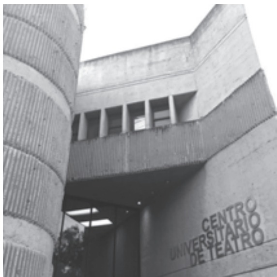
Fațada clădirii Centrului Universitar al Teatrului (CUT), școala creată de Héctor Mendoza, care face parte din Centrul Cultural Universitar al UNAM, Mexic ( http://oferta.unam.mx/cut.html )
